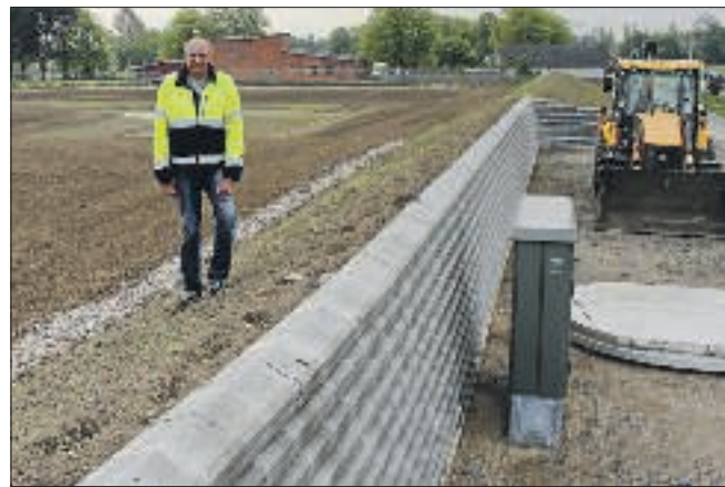
Jan Smedegaard fra Klar Forsyning står her på volden med den indbyggede pumpestation, der afgrænser Nicolinelund ud mod Stevnsvej. I baggrunden ses regnvandsbassinet, der opsamler regnvand fra det nye boligområde. Privatfoto
